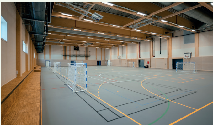
Idretshallen er bygget med ytterveggselementer i massivtre og limtredragere som bærer lettaket. Foto: WhyConnect
