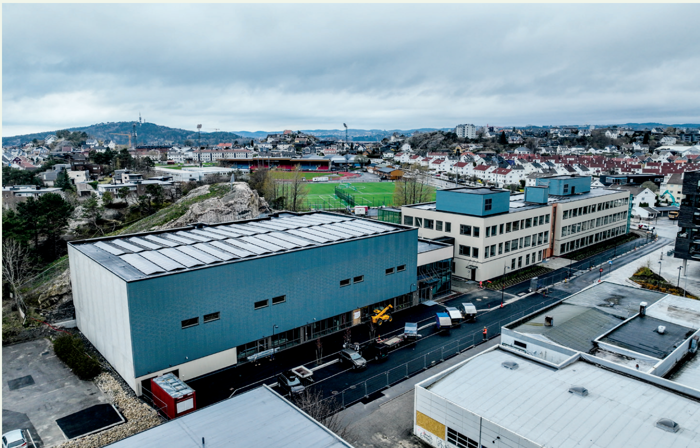
Wilds Minne skole og flerbrukshall er bygget i bydelen Lund i Kristiansand. I første etasje av hallbygget er det etablert næringsarealer ut mot bakkeplan.
